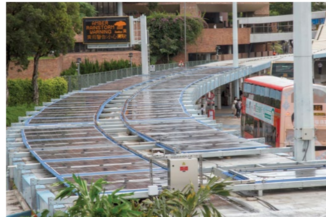
為推廣使用可再生能源，我們為路政署在紅磡海底隧道東面入口的有蓋行人道安裝太陽能發電系統，以供應電力給接駁行人天橋的自動梯。
