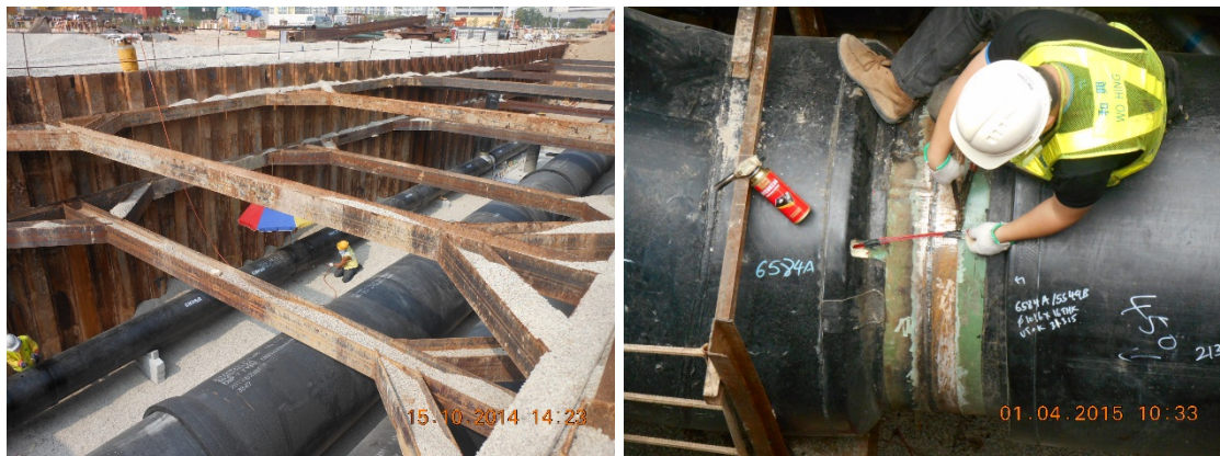
图 7. DCS系统管道焊接的非破坏性试验
