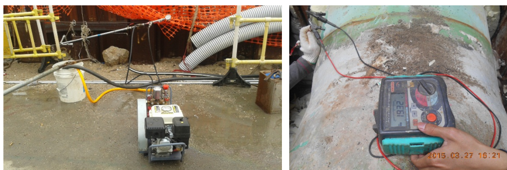
图 8. DCS系统管路水压测试和嵌入式渗漏监测电缆测试
