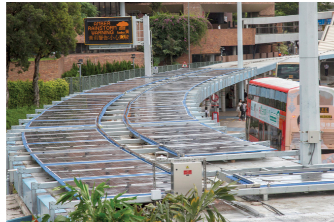
為推廣使用可再生能源，我們為路政署在紅磡海底隧道東面入口的有蓋行人道安裝太陽能發電系統，以供應電力給接駁行人天橋的自動梯。
