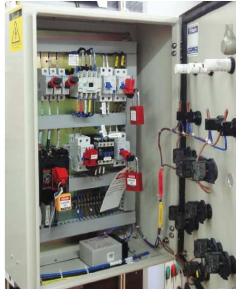
圖 1：機器設備的能源必須切斷並上鎖。
