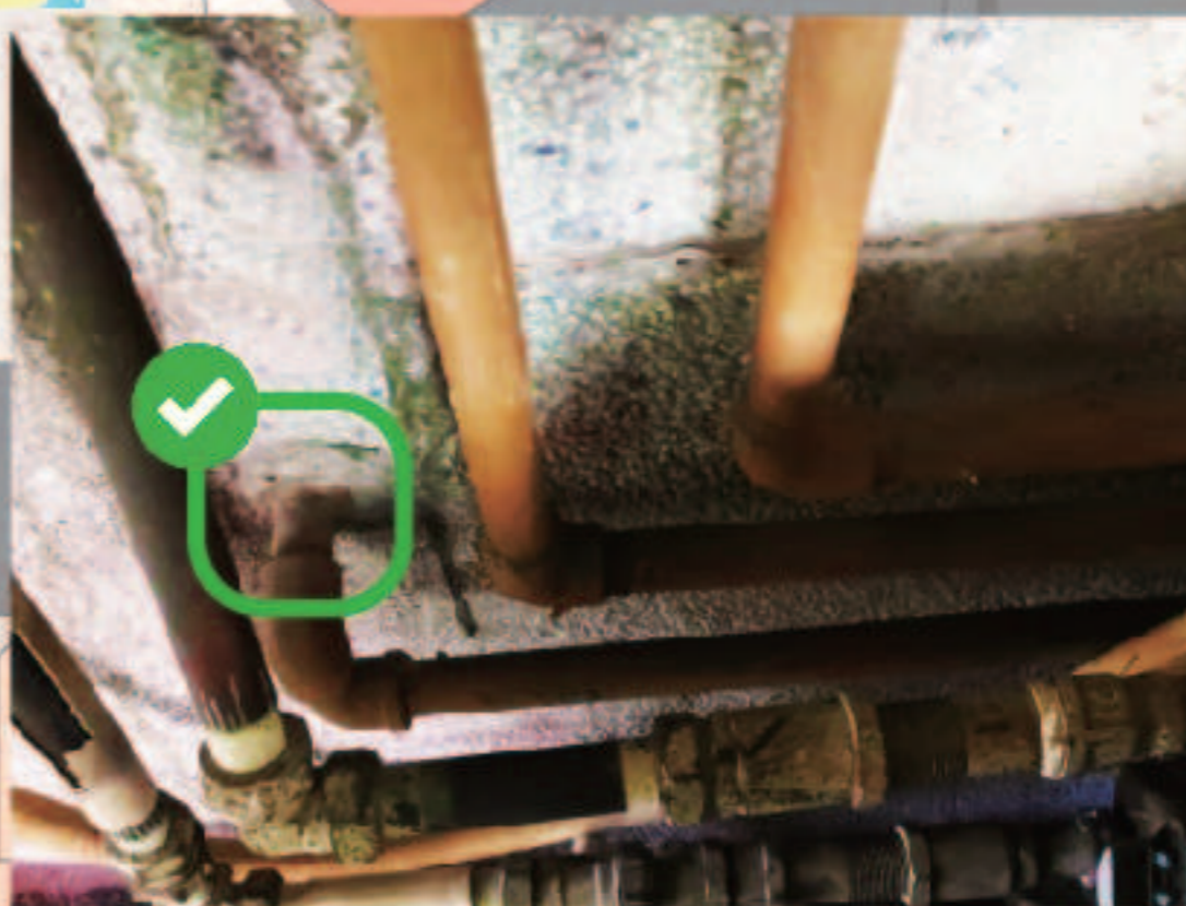
✔ 使用金屬氣體喉管穿過外牆
