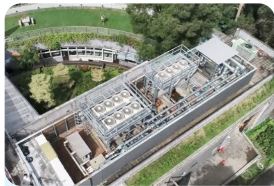
大龍獸醫化驗所更換製冷機組項目採用多種先進技術，例如運用「機電裝備合成法」技術預製機電組件，是行業發展的里程碑。圖為項目完成後的場地鳥瞰圖。
