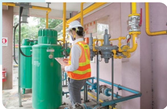
我們安排在美孚新邨的中央石油氣儲存庫安裝「氣體偵測連鎖系統」，並在儲存庫的不同區域設置氣體洩漏感應器，當某個區域出現氣體洩漏，系統便會立即啟動應急程序。
