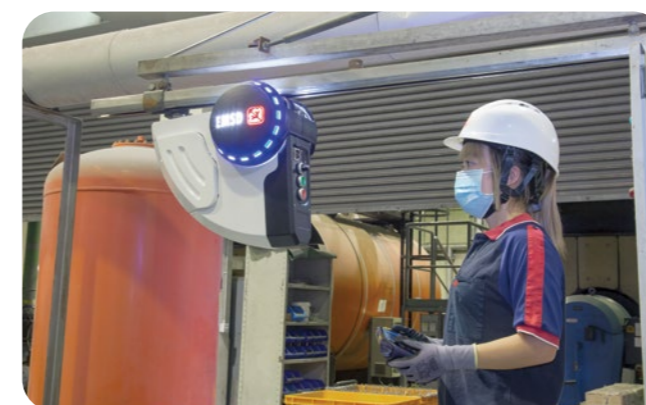
機電署人員在屯門蝴蝶灣洗衣房利用智能路軌維護機械人進行路軌清潔和檢查。
