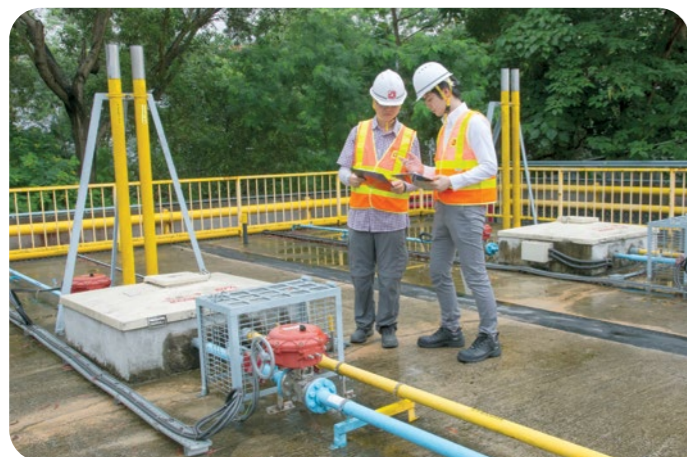
我們安排在美孚新邨的中央石油氣儲存庫安裝「氣體偵測連鎖系統」，並在儲存庫的不同區域設置氣體洩漏感應器，當某個區域出現氣體洩漏，系統便會立即啟動應急程序。
