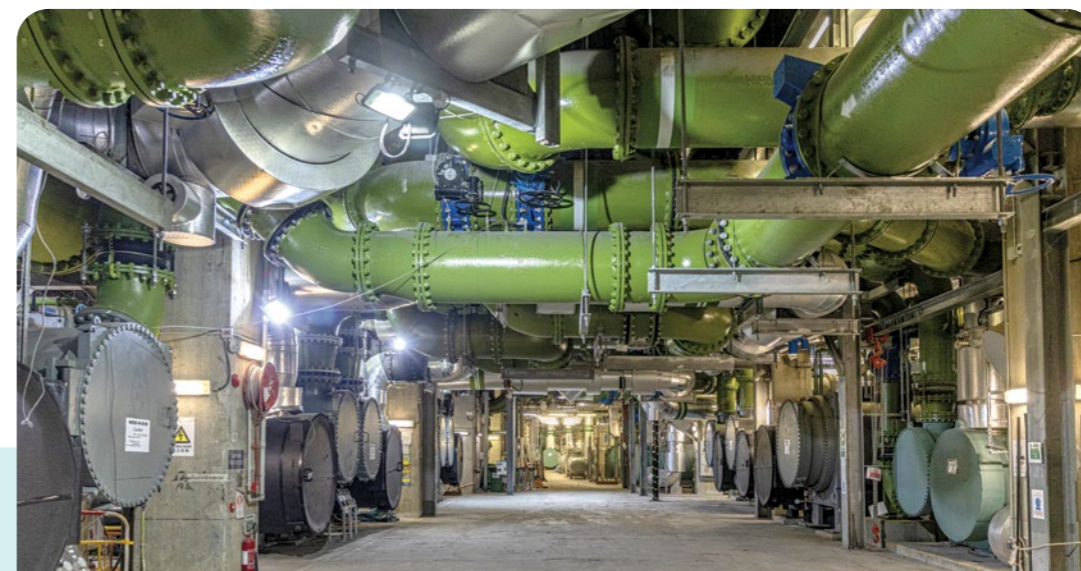
機電署在啟德發展區建造區域供冷系統，以提升能源效益，減少碳排放量和紓緩熱島效應。啟德區域供冷系統現時共有兩座製冷廠房，自2013年起投入運作。
