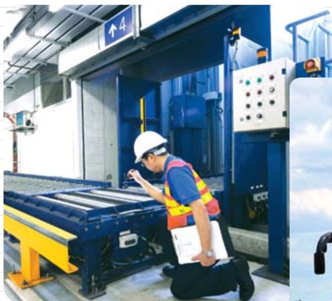
檢查機場新海天客運碼頭行李處理系統。 Inspecting the Baggage Handling System at the new Airport Skypier.
