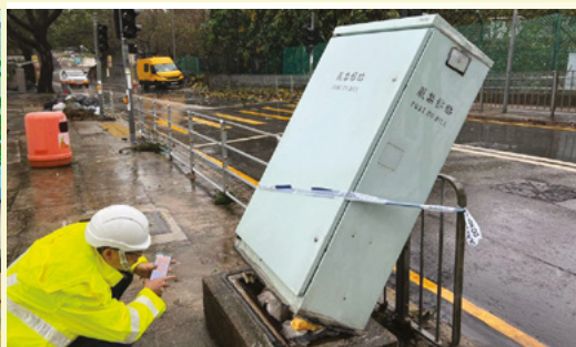
搶修公共機電設施
